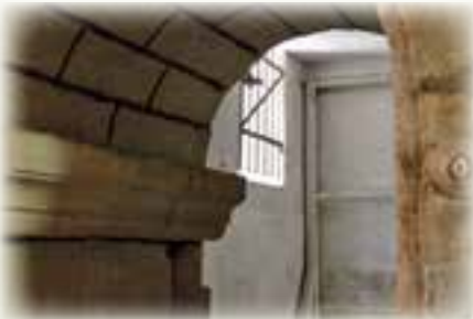
Blick in ehemalige Arrestzelle, 2020 (Bild: HLZ)
